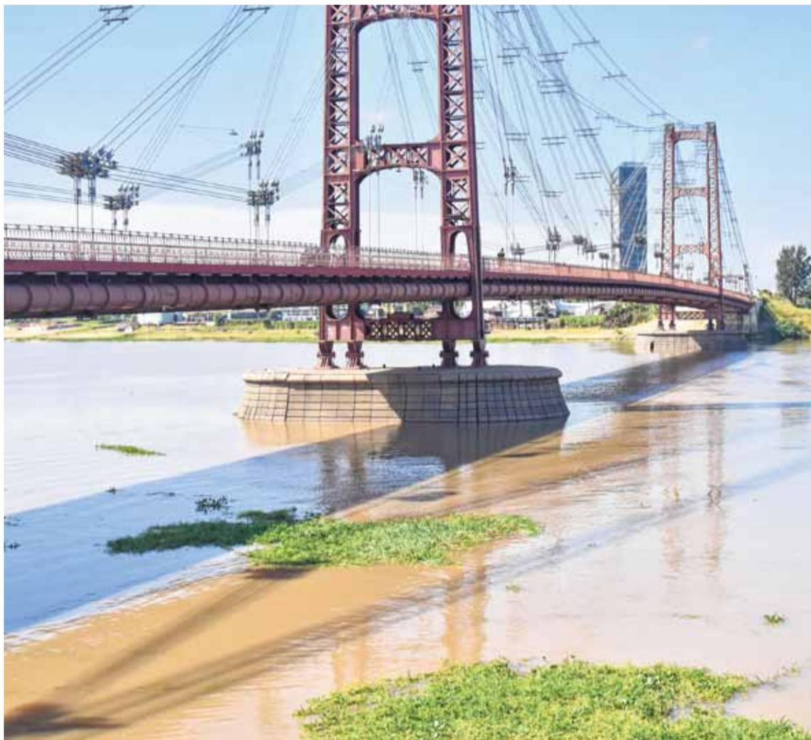
**EFFECTOS.** El fenómeno de La Niña provocó islas, sedimentación y una reducción de la capacidad de conducción de caudales.
